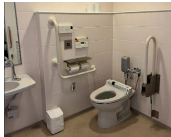
⑩3Fトイレ(女子、 車いす)
