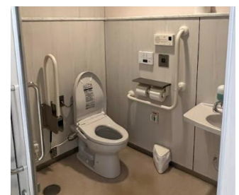
⑫4Fトイレ(女子、 車いす)
