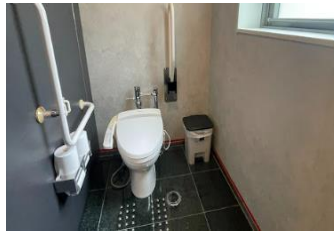
⑰2Fトイレ(女子、車いす)
